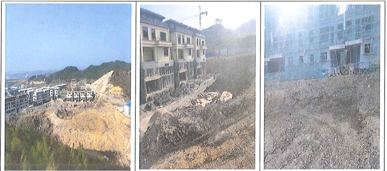
图 3-1 调查地块内部现场踏勘图
