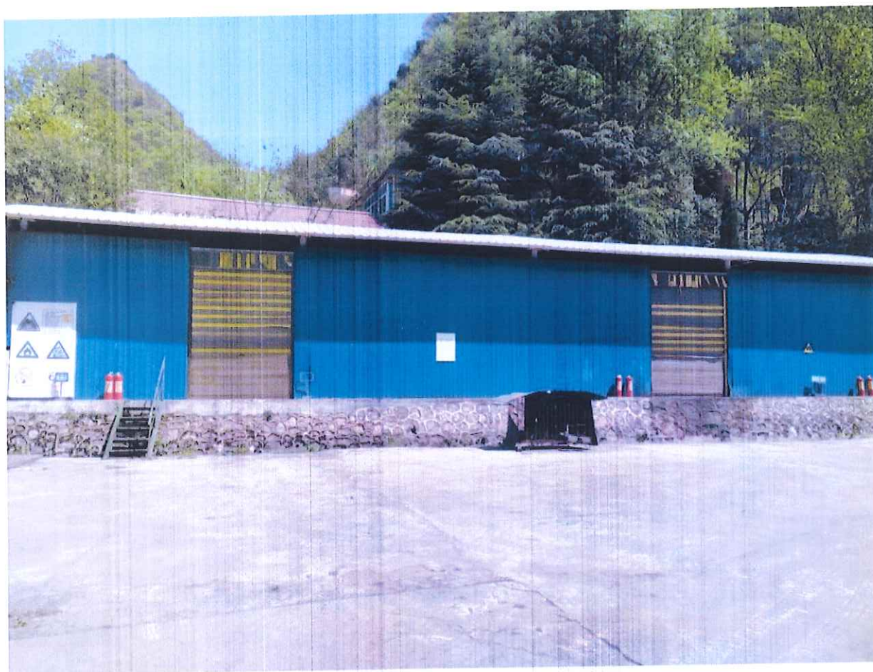
附图 5 危废暂存间照片
