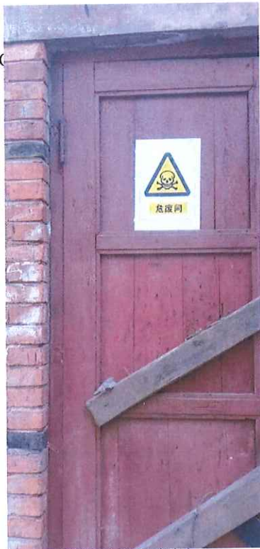
危险废物暂存间
