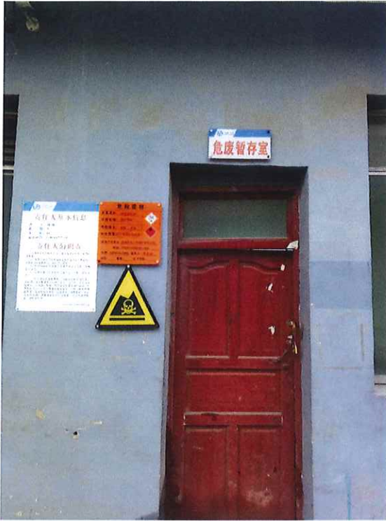
附图 6 危废暂存间
