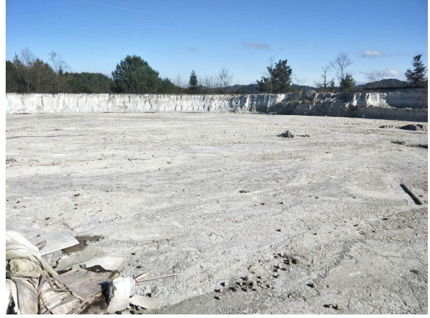
原龙里新龙乙炔有限公司电石渣场现状图
