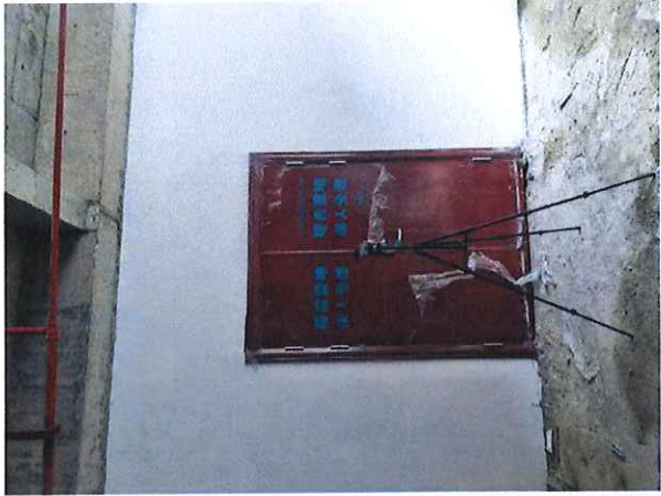
3,4#楼下水泵房外噪声监测点 N4
