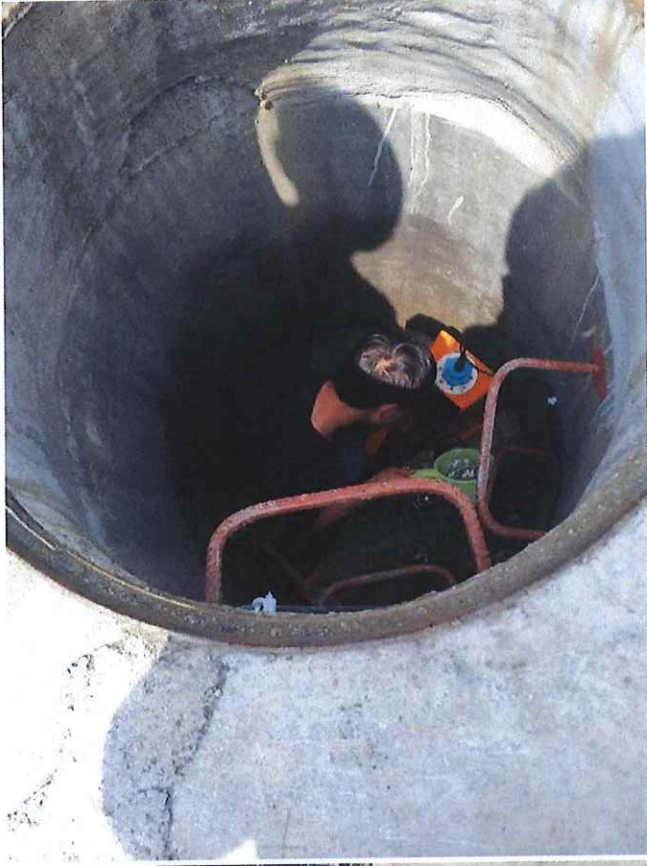
污水处理设备进口监测点 FS1
