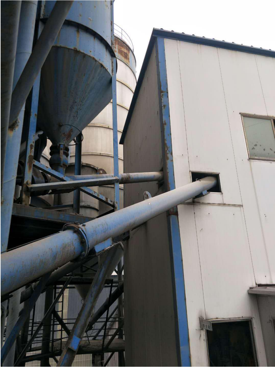
附图 5 粉尘回用装置
