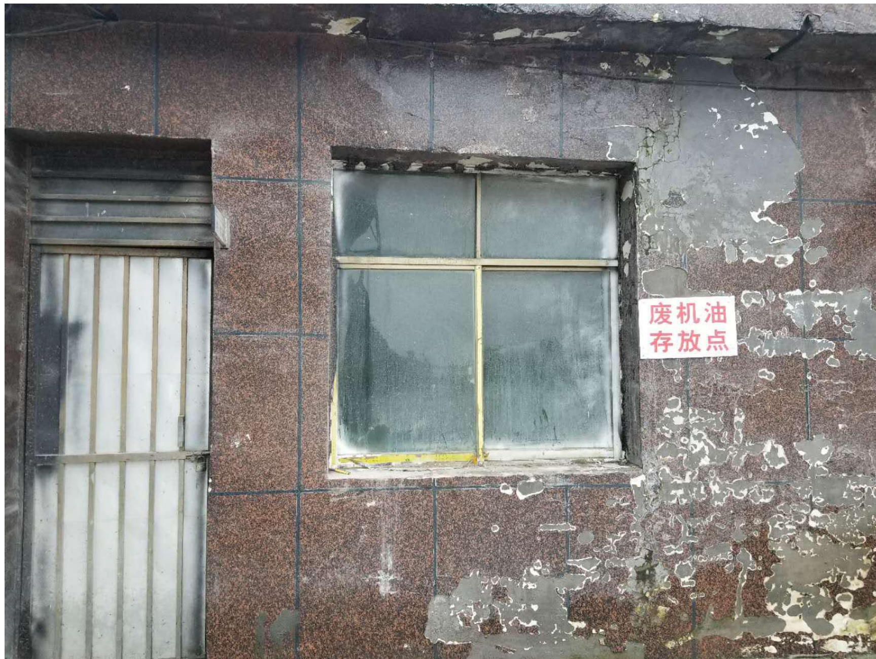
附图 4 危废暂存间
