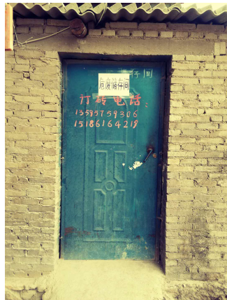
危险废物暂存间
