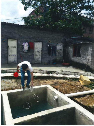
污水处理设施进口监测点 FS1
