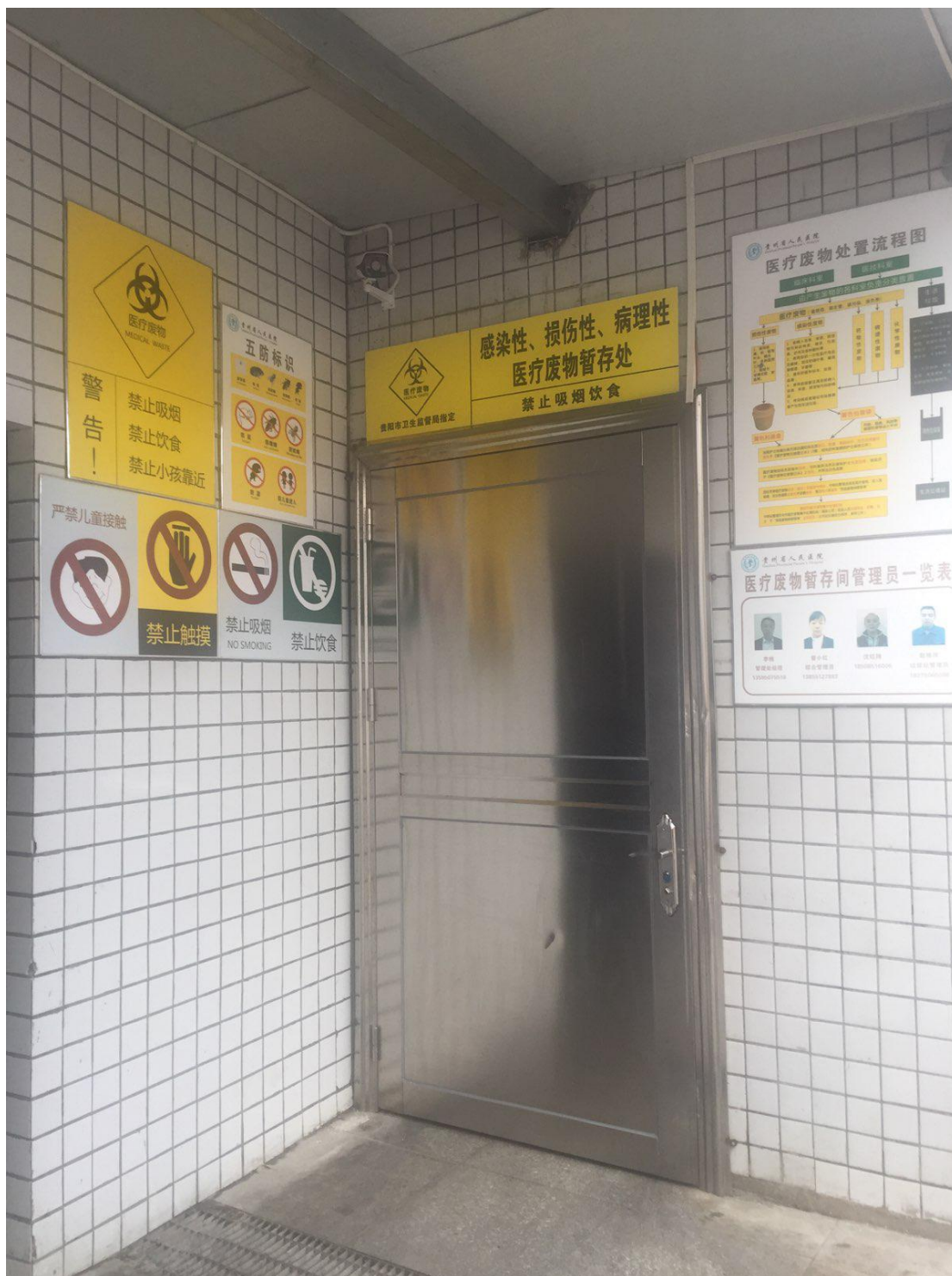
附图2 危废暂存间
