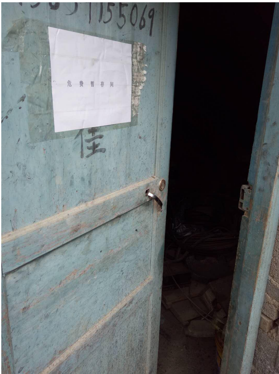
附图3 危废暂存间
