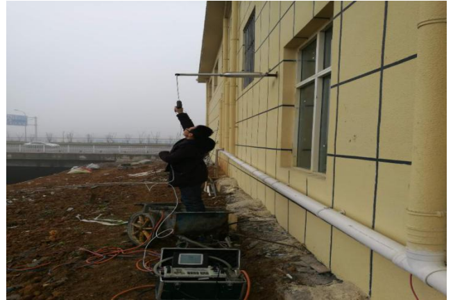
柴油发电机排气筒出口
